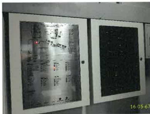
แผงควบคุมระบบสัญญาณแจ้งเหตุเพลิงไหม้ ตำแหน่งหรือพื้นที่ที่เกิดเหตุเพลิงไหม้
