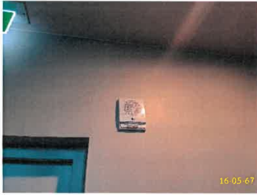
อุปกรณ์แจ้งเหตุเพลิงไหม้ด้วยเสียง และแสงไฟกระพริบ
